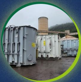
Armazenagem e Movimentação Portuária
